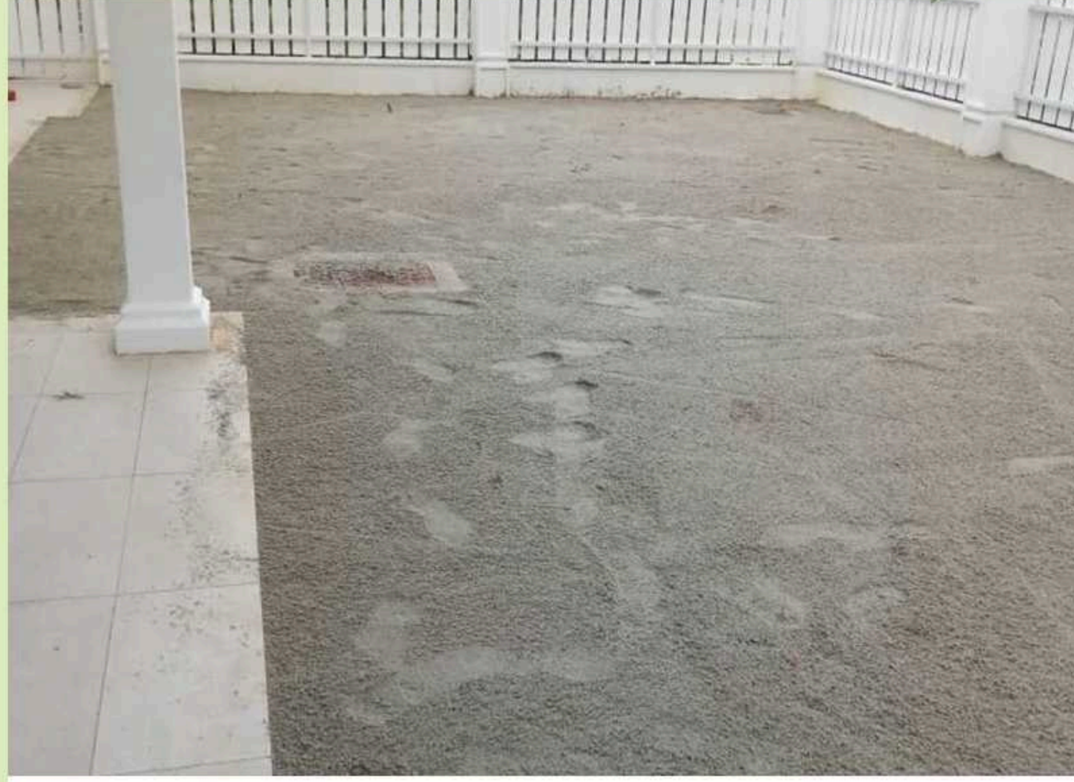
2. Ratakan tanah dengan pasir halus & mampatkan
