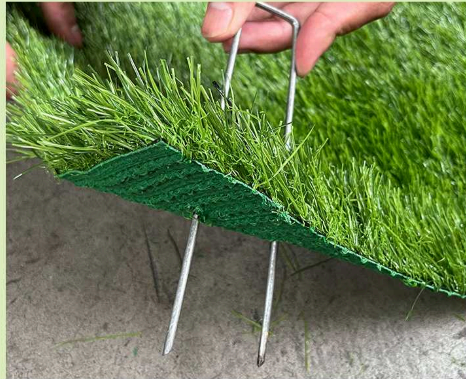
5. Tambah paku U untuk lebih tahan lasak dan tidak bergerak
