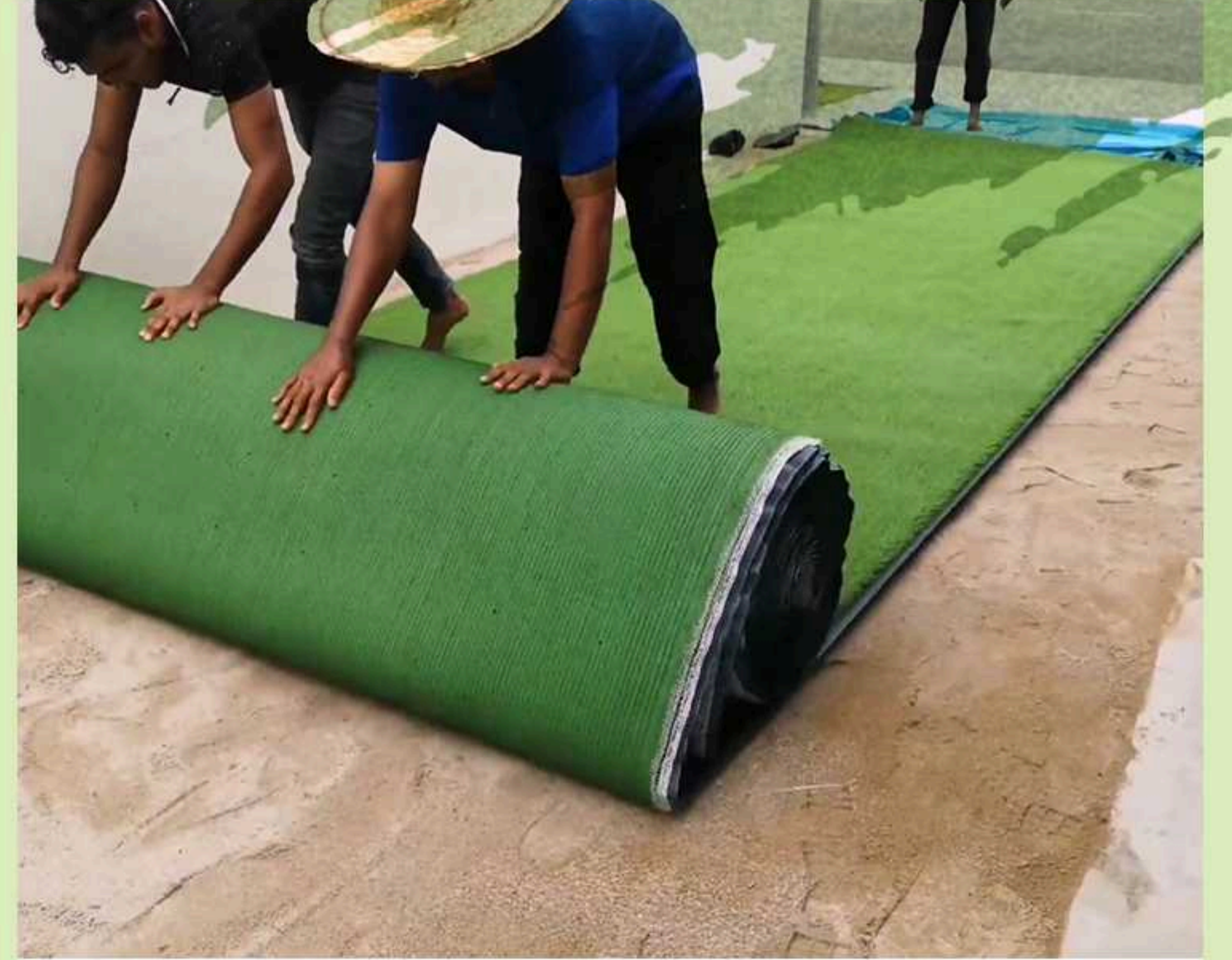
3. Bentangkan rumput di atas tanah
