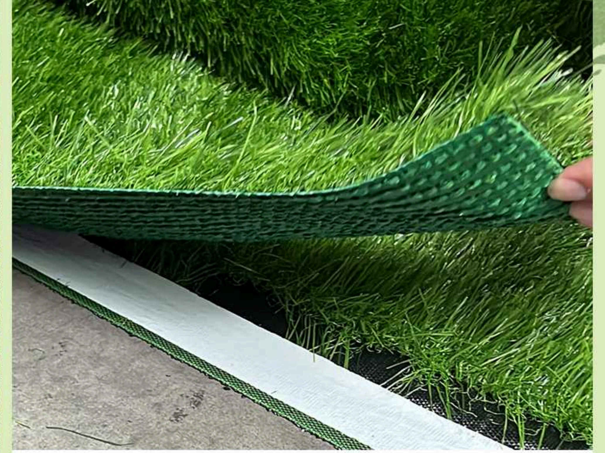
3. Sambungkan rumput tiruan menggunakan double sided tape
